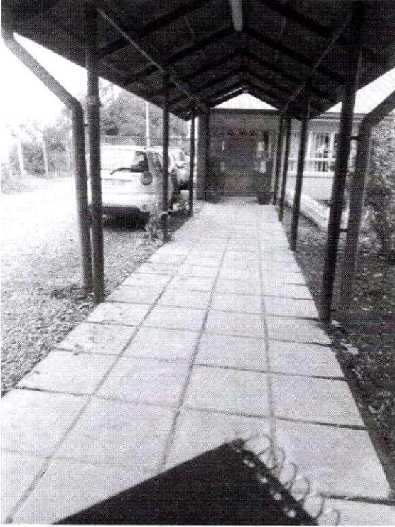
PASILLO ENTRADA ESCUELA
